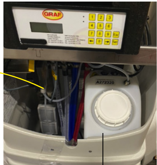
Dunk för fällningsmedel integrerad i styrskalet
